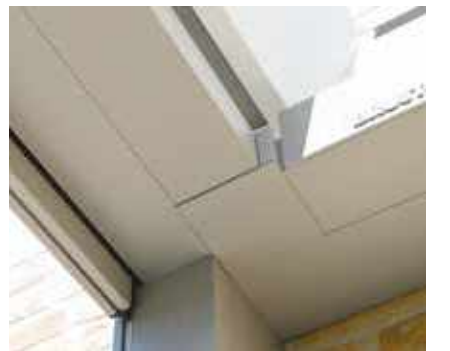
Wasserabfuhr von der Regenrinne direkt in den Stützpfeiler
