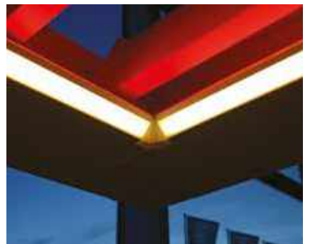
Die Regenrinne kann auch mit einer direkten und/oder indirekten LED-Beleuchtung erweitert werden
